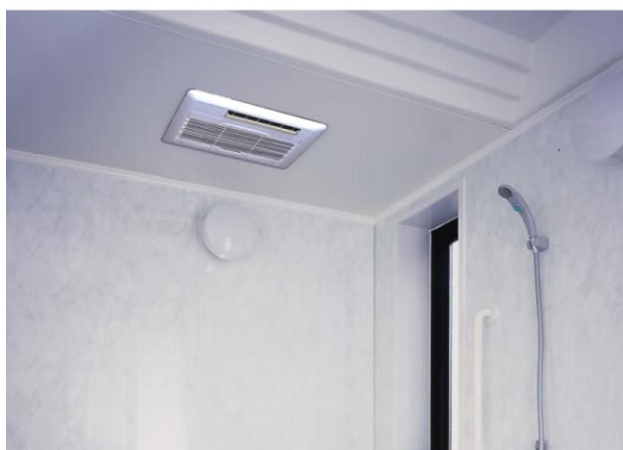
浴室の天井に設置
