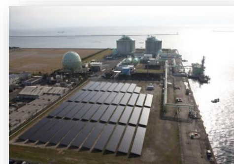
鹿児島工場メガソーラー発電所
