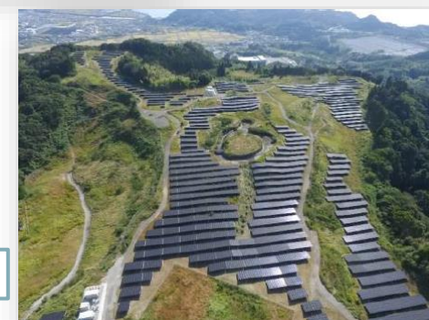
加治木メガソーラー発電所
