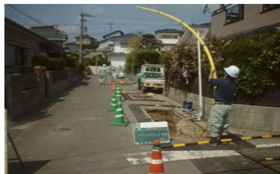
非開削工法による導管工事
